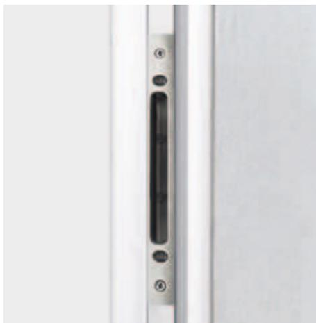
Einzelschließblech im Türflügel
